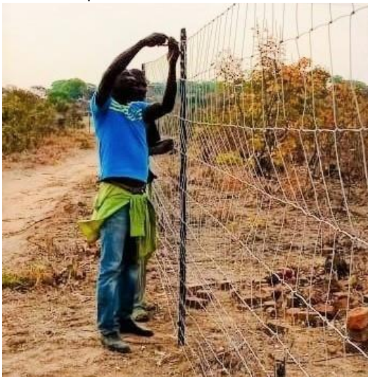
Humphrey Sekeleti druk doende met het plaatsen van een omheining.
